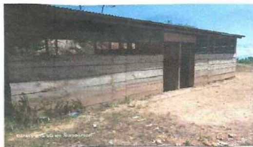
Foto 4: Mejoramiento de aulas tipo portico
