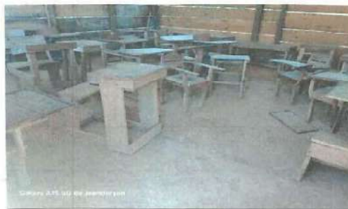
Foto 2: Mejoramiento de piso torta de cemento
