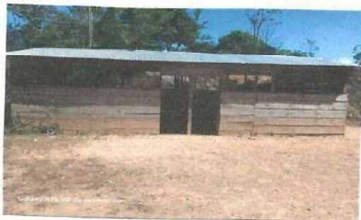
Foto 1: Mejoramiento de aulas tipo portico
